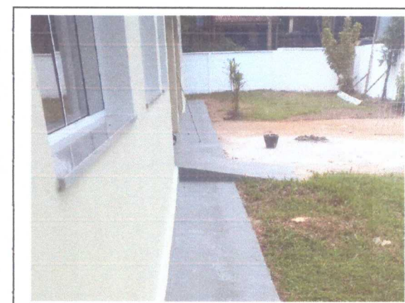
RAMPA DE ACESSIBILIDADE e PNTURA CALÇADA
