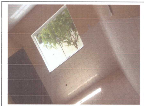
REFORMA DA COZINHA
