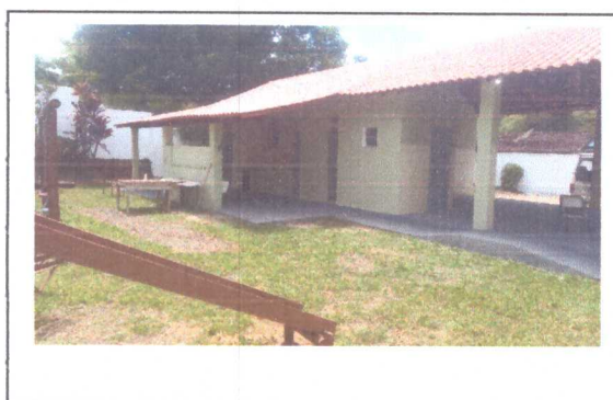
PINTURA, TELHADO e PARQUINHO
